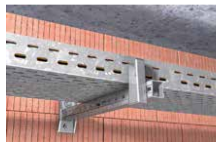
Staffaggio di impianti elettrici
